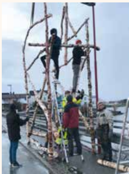
Roverne bygger portal natt til 16.mai, også det i nordvest vind og sluddbyger. Klokka er over midnatt.
